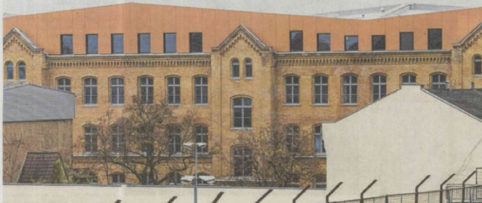
Das vom halleschen Architekten Matthias Dressler entworfene Dach auf Halles künftiger Jugendherberge ist ungewöhnlich.
